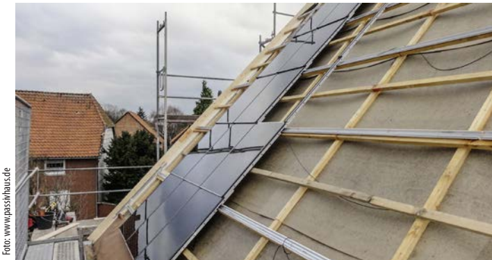
Beim Nd-System werden horizontale und vertikale thermische Bewegungen abgefangen.
