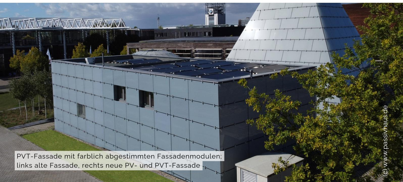
PVT-Fassade mit farblich abgestimmten Fassadenmodulen; links alte Fassade, rechts neue PV- und PVT-Fassade
